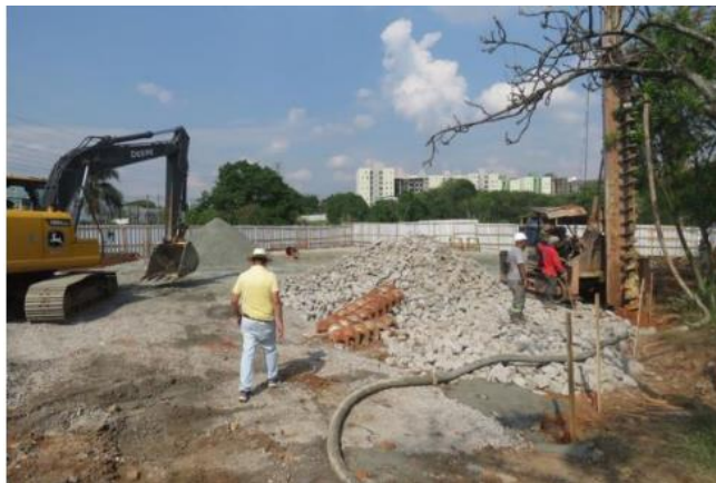
Santo André começa obras da Estação de Coleta Parque Marajoara
