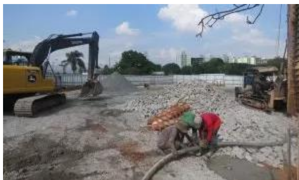
Construção da Estação de Coleta Pq Marajoara (17) (Copy)
