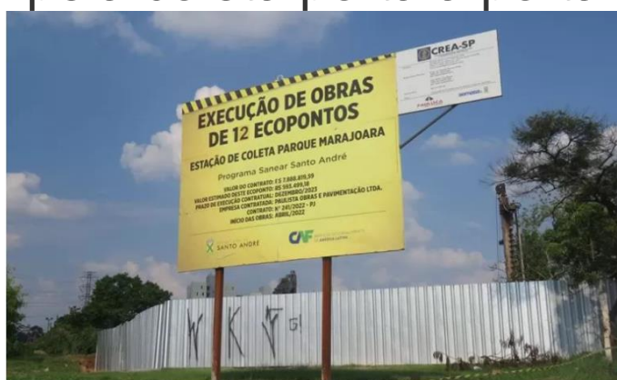
Construção da Estação de Coleta Pq Marajoara (26) (Copy)
