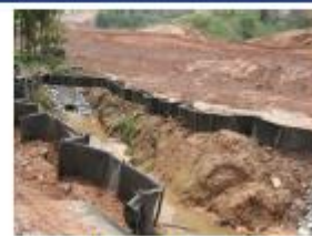
Manta geotêxtil na proteção de cursos d'água
