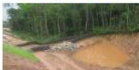
Bacia de retenção de sedimentos
