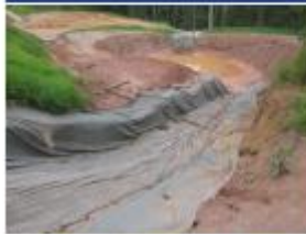
Descida d'água provisória e bacia de retenção de sedimentos
