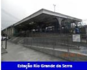
Estação Rio Grande da Serra
