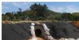
Proteção de taludes de aterro e cursos d'água
