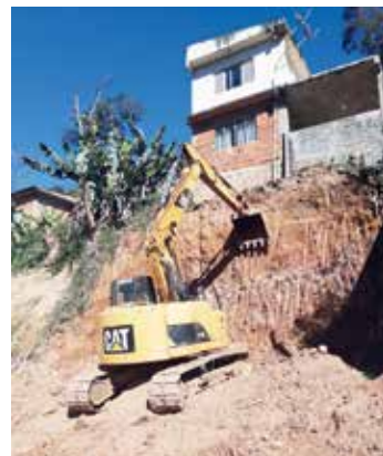
Flagrante de movimentação de terra no Recreio da Borda do Campo
