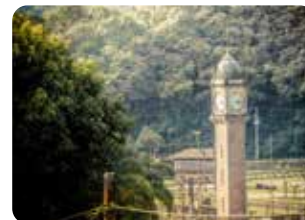
Reformas em duas edificações do Patrimônio Histórico
