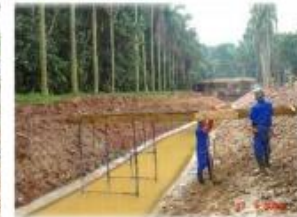
Obra do projeto de renaturalização do Córrego Pirarungáua
