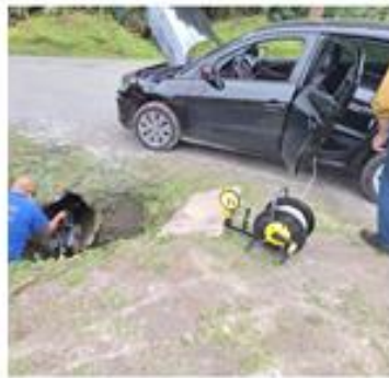
Filmagem em galeria de águas pluviais - Parapiscaba
