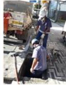
Limpeza de bocas de lobo
