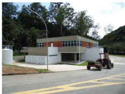
Vista da sede administrativa
