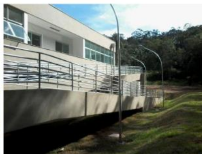
Rampa de acesso para deficientes físicos para a sede administrativa
