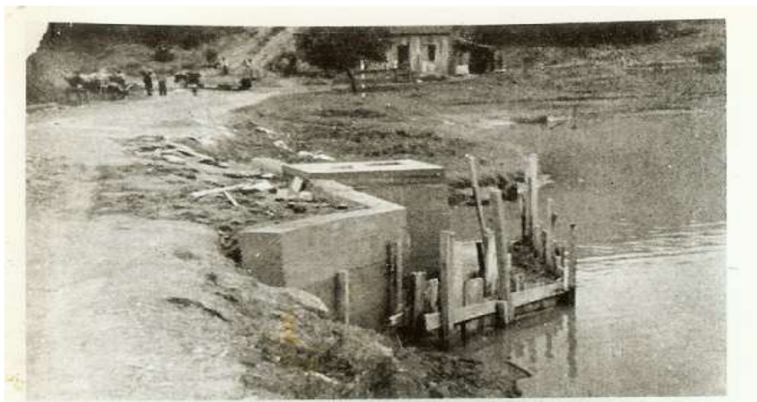
Figura 9: Construção da caixa de registro e barragem da Lagoa do Pedroso, no alinhamento da Estrada para Santo André (depois Estrada do Pedroso) para o vertedor à esquerda para o reservatório Billings, 1955.
