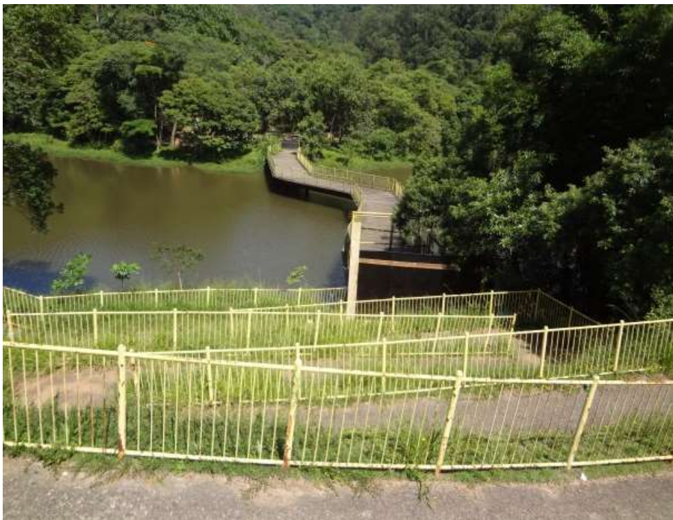
Figura 69: Ponte de acesso.
