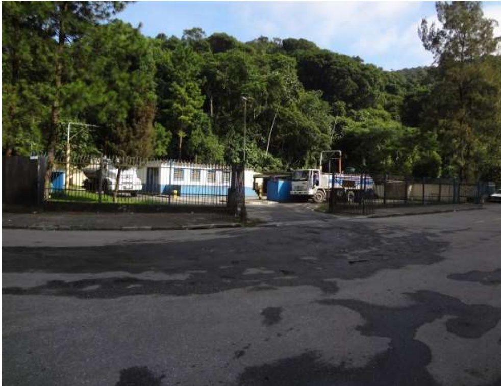
Figura 72: Estação de bombeamento de água.
