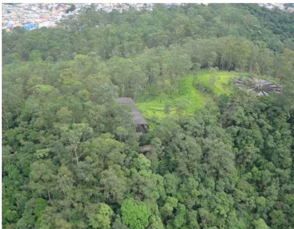
Figura 94: 3ª torre do teleférico (desativado).
