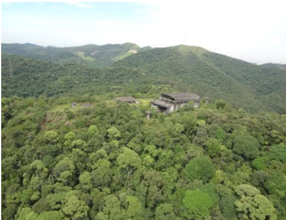
Figura 93: 2ª torre do teleférico (desativado).
