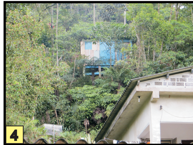
4 Residências de alta vulnerabilidade construídas em encosta íngreme
