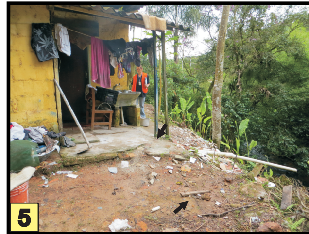
5 Moradia interditada por instabilidade do solo de aterro abaixo, com lançamento de águas servidas diretamente no talude, aparentemente a moradia encontra-se reocupada.
