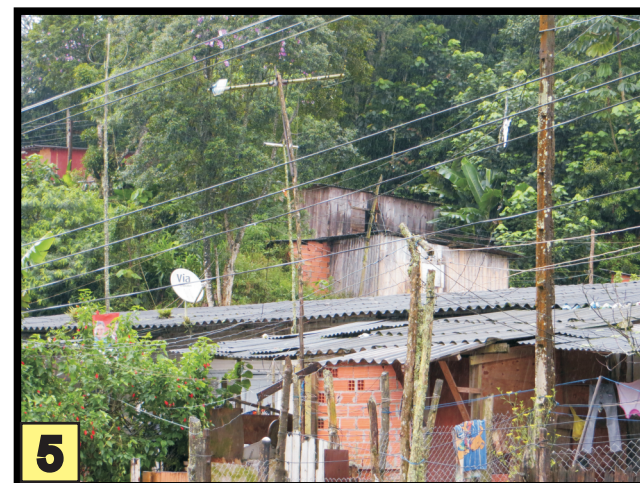
Construções mistas nas encostas e topo de morros. As moradias mais baixas estão sujeitas a enxurradas por se localizarem em áreas de talvegues de encostas elevadas.
