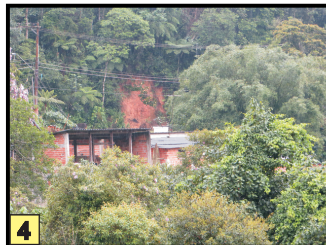
Deslizamento de solo em corte de cerca de 90°.
