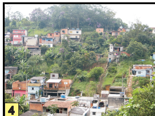
4 Área com muito alto risco a ocorrência de deslizamento, devido a inclinação natural da encosta e agravado pelas ocupações e intervenções não adequadas.
