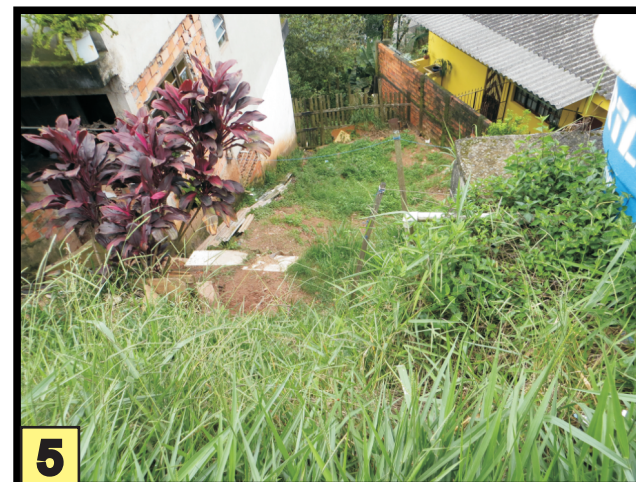
5 Deslizamento de solo em encosta de alta inclinação.
