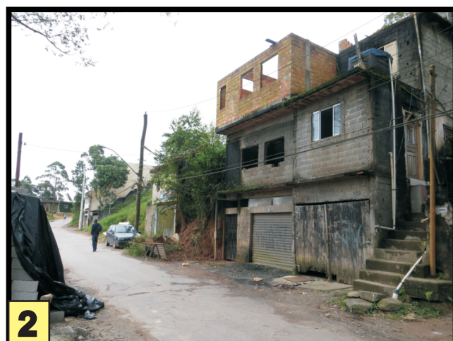
2 Deslizamentos de solo.
