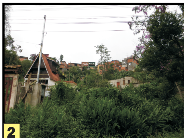
Moradias na beira de crista de encosta concava em forma de anfiteatro, indícios de deslizamentos anteriores, e muito alto risco de novos eventos.
