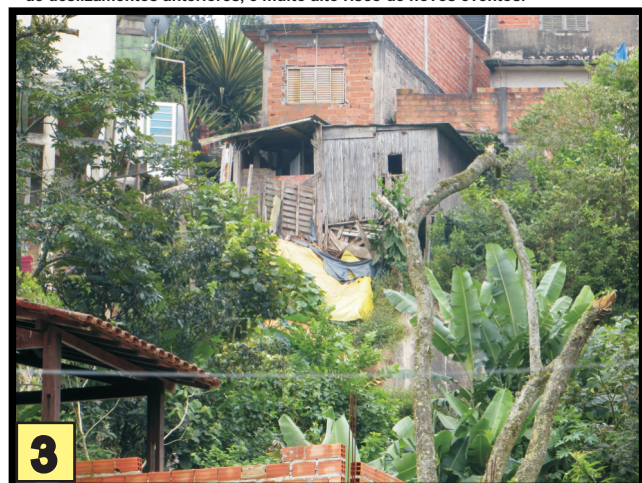
Moradias em anfiteatro com ocorrências de deslizamentos de solo.
