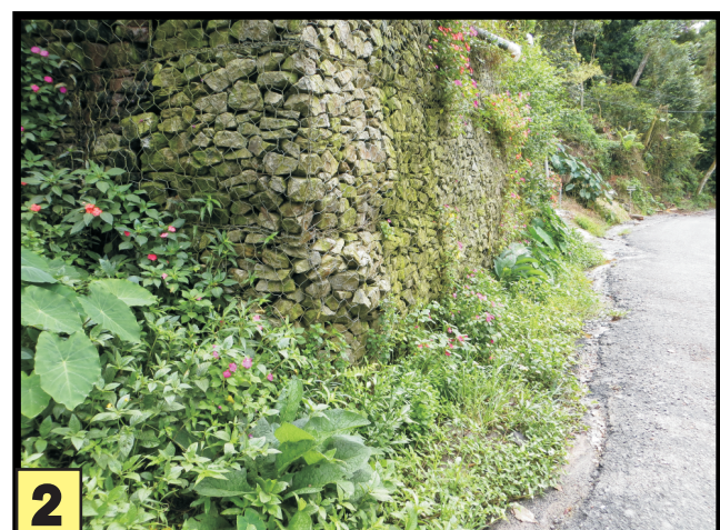
2 Muro de gabião com "embarrigamento", devido ao peso excessivo do terreno acima.
