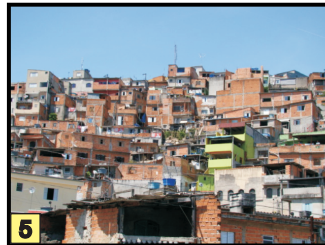
5 Ocupação desordenada da encosta, com sucessivos cortes subverticais e aterros lançados, alta possibilidade de infiltrações no solo por vazamentos da rede de esgoto e drenagens de águas pluviais.
