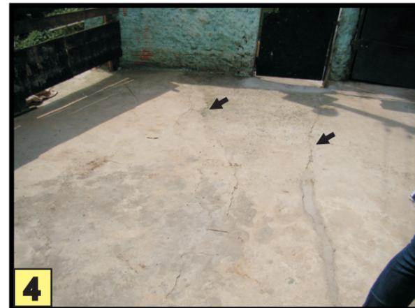
**4** Pavimento com trincas originadas pela movimentação do solo devido ao solapamento das margens em processo de avanço.
