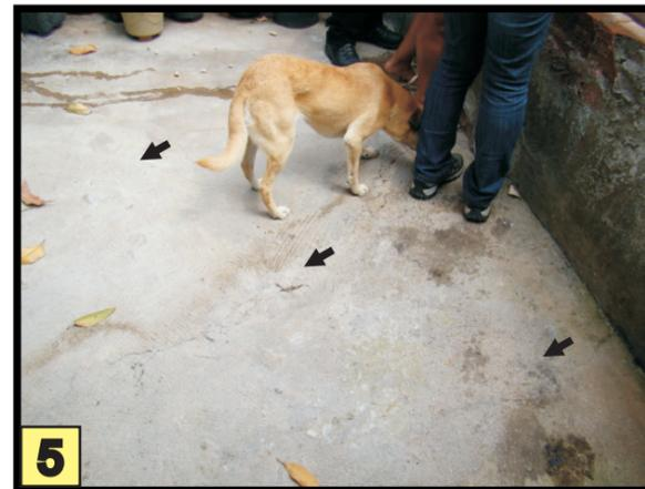
**5** Moradia com pavimento trincado oriundo do processo de solapamento das margens ainda em processo de avanço.
