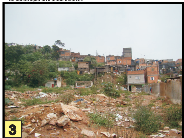
3 Moradias em encosta, construídas sob intervenções inadequadas de corte e aterros, e sem drenagem de águas pluviais e saneamento adequado.
