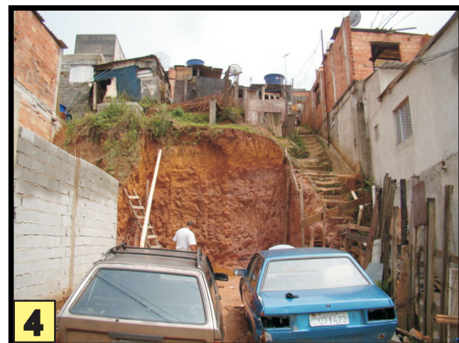
4 Exemplo de intervenção inadequada em encosta, colocando em risco de deslizamento as moradias ao redor.
