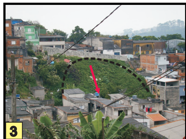
Deslizamento planar de solo sobre solo já ocorrido.
