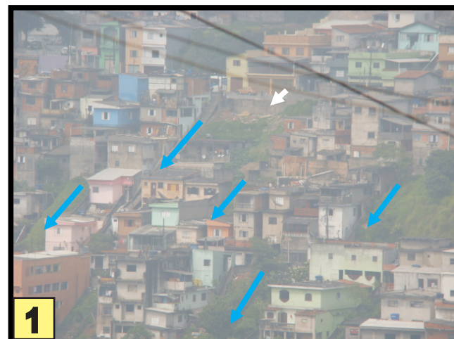
Encosta densamente ocupada por moradias em cortes verticais e aterros lançados, com alta possibilidade de infiltração de água no solo.
