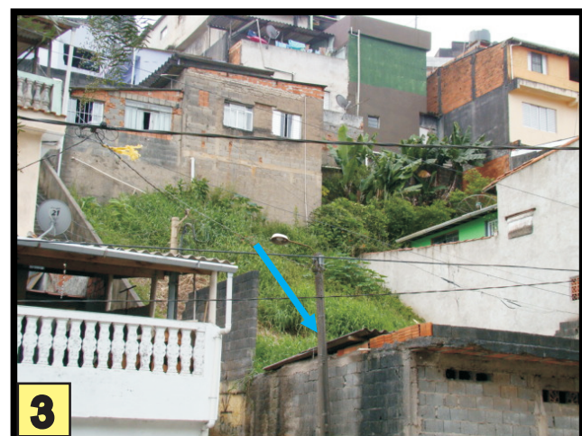
3 Ocupação de encosta com intervenções inadequadas na forma de taludes de corte verticais e lançamento de águas pluviais ou servidas na encosta.
