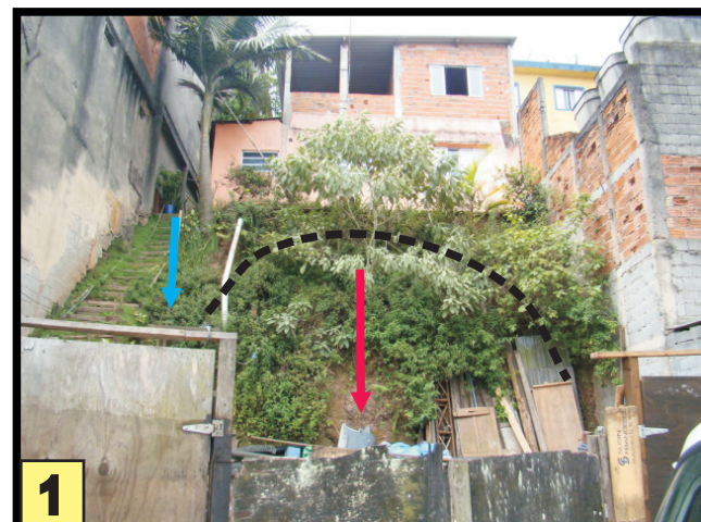
1 Moradia em alto risco de deslizamento devido a intervenção inadequada na base na forma de talude de corte vertical.
