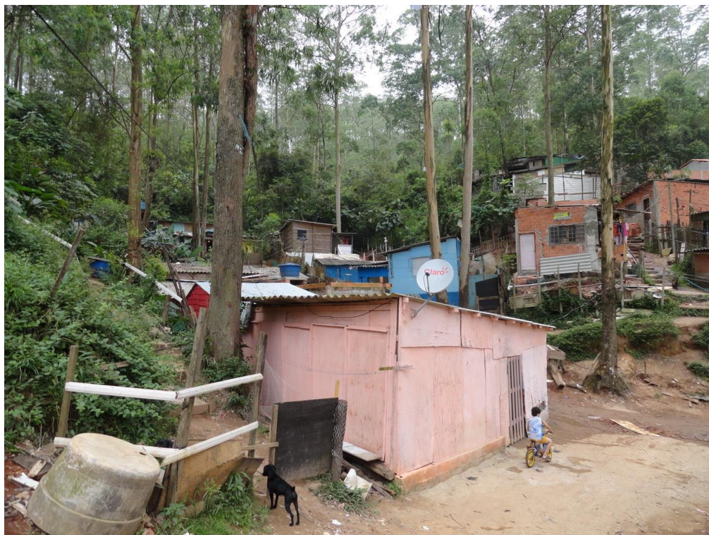
Foto FC-STA-20-01.03: Detalhe da precariedade dos acessos.
