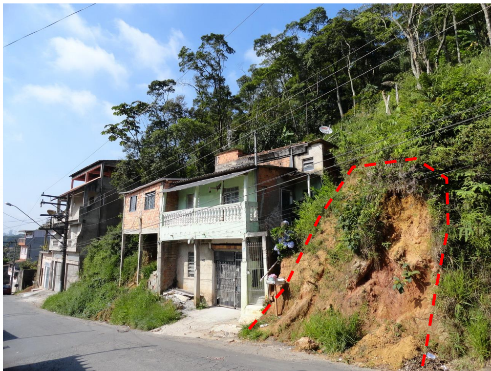
Foto FC-STA-27-01.01: Notar a proximidade das moradias com relação a base da encosta e dos taludes de corte e a presença de cicatriz de deslizamento (tracejado vermelho)
