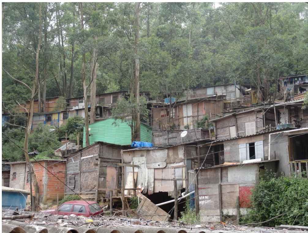
Foto FC-STA-20-01.07: Detalhe do baixo padrão construtivo e da grande quantidade de moradias em madeira.
