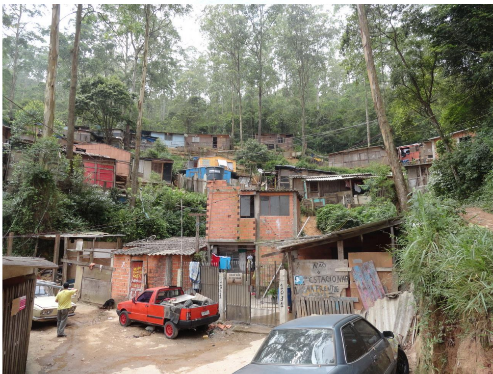
Foto FC-STA-20-01.06: Moradias de baixo padrão construtivo, sob grandes eucaliptos. Notar a altura e inclinação elevadas da encosta.
