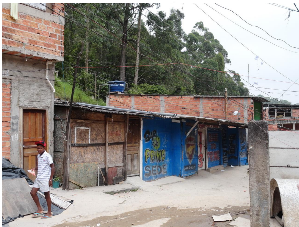
Foto FC-STA-20-04.01: Moradias de baixo padrão construtivo, em madeira.
