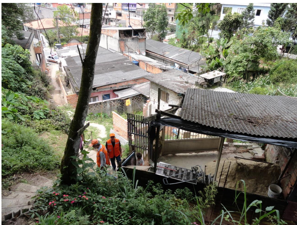
Foto FC-STA-26-01.02: Vista das moradias localizadas na base e meia encosta do anfiteatro de drenagem presente na área.
