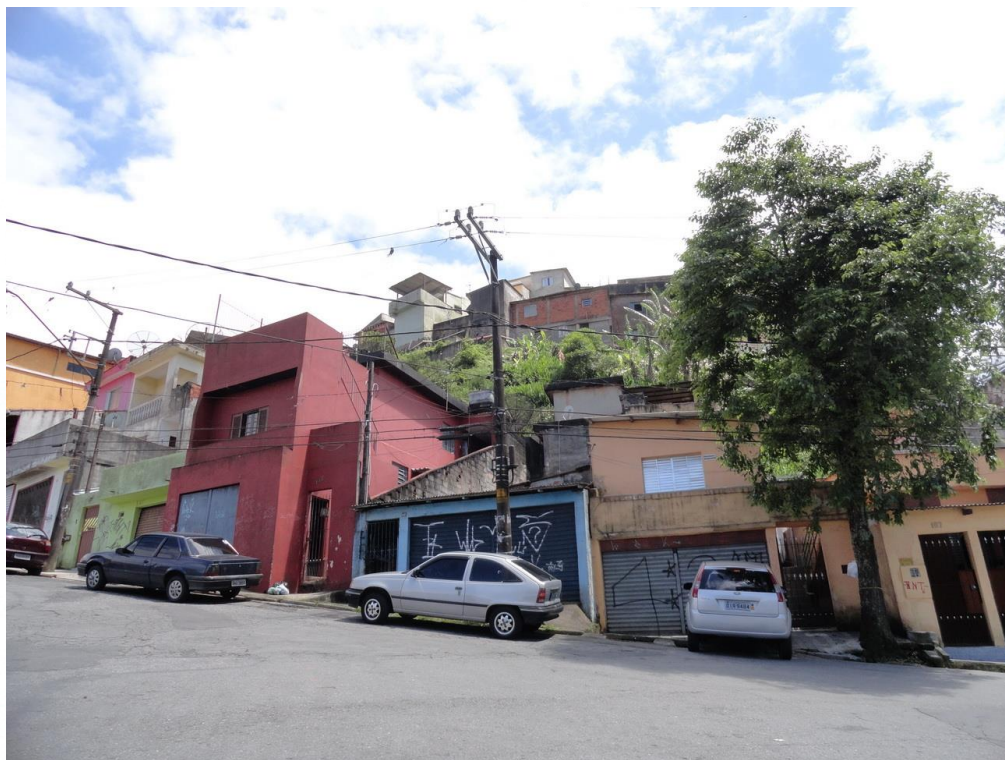
Foto FC-STA-19-01.01: Detalhe das moradias de bom padrão construtivo no setor, na base do talude.
