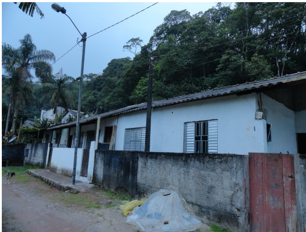
Foto FC-STA-32-03.01: Notar, ao fundo das moradias, o talude de corte com altura e inclinação elevadas.
