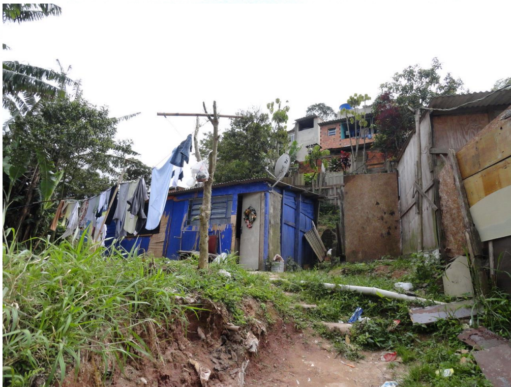
Foto FC-STA-25-01.02: Detalhe das moradias de baixo padrão construtivo no setor, próximas ao topo de um talude de corte, apresentando depósito antrópico de aterro sobre o mesmo.
