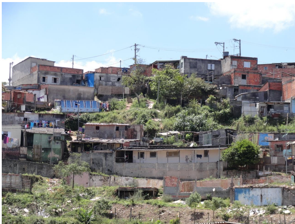
Foto FC-STA-21-01.01: Vista geral do setor. Notar a presença de taludes de altura e inclinação elevadas e a presença de moradias em madeira.
