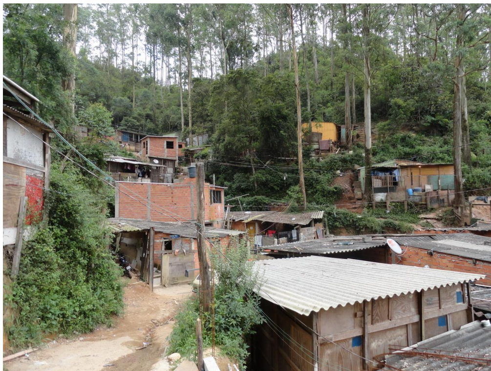
Foto FC-STA-20-01.05: Vista de outro anfiteatro de drenagem em meio ao setor.
