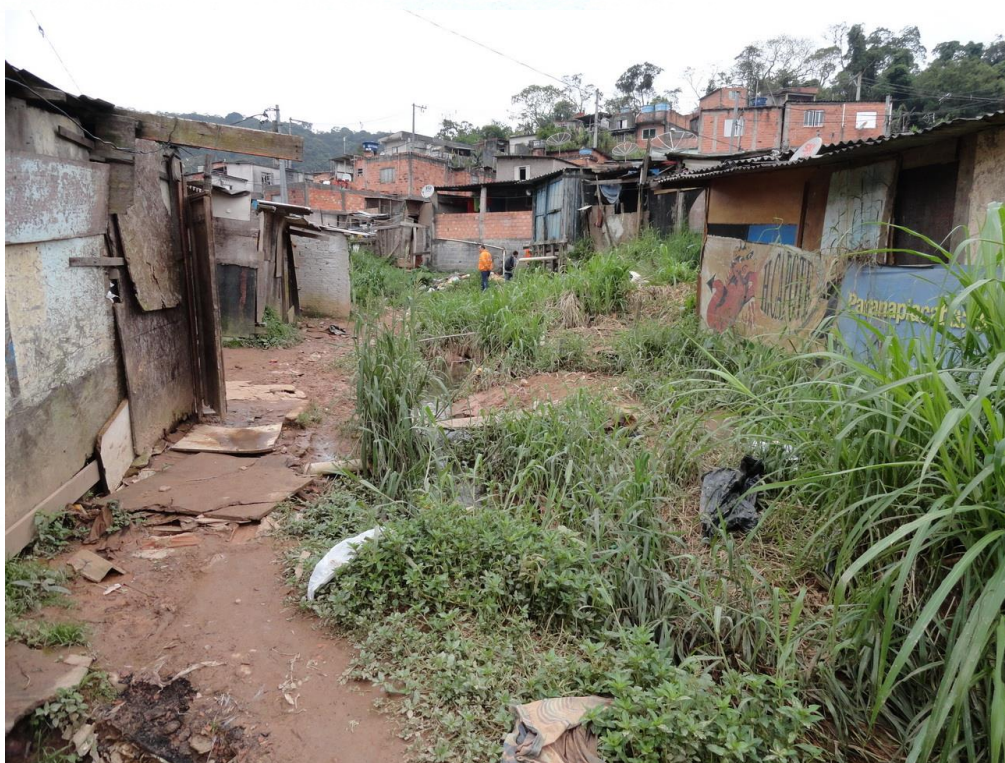
Foto FC-STA-23-01.02: Vista parcial do curso d'água e das moradias em seu entorno. Notar a pequena altura do talude marginal.
