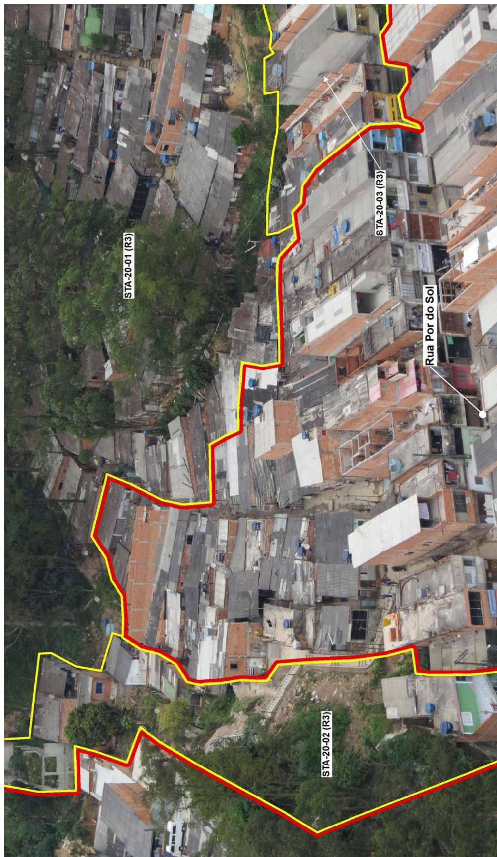
FOTO FH- STA-13.02: Vista dos setores mapeados.
