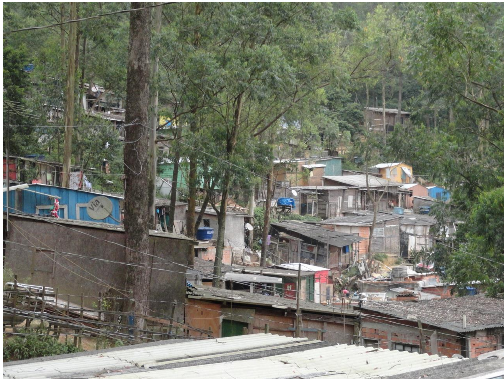
Foto FC-STA-20-01.04: Notar a presença significativa de moradias de baixo padrão construtivo.
