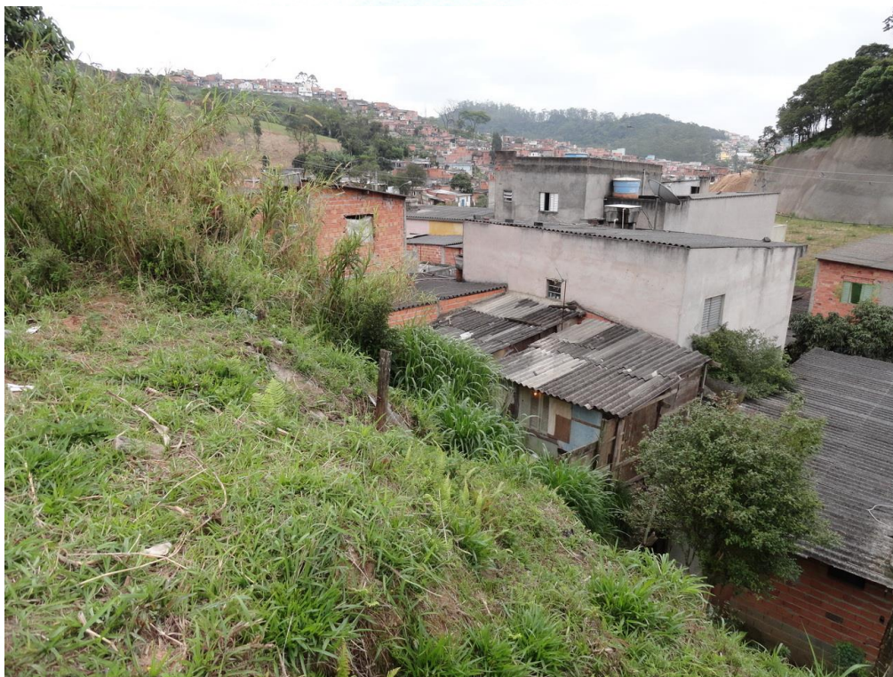
Foto FC-STA-23-02.02: Vista a partir do topo do talude de corte. Observa-se na base uma das moradias de madeira do setor.
