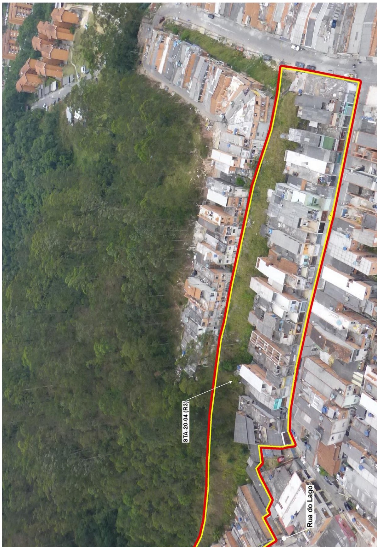
FOTO FH- STA-13.06: Vista dos setores mapeados.
