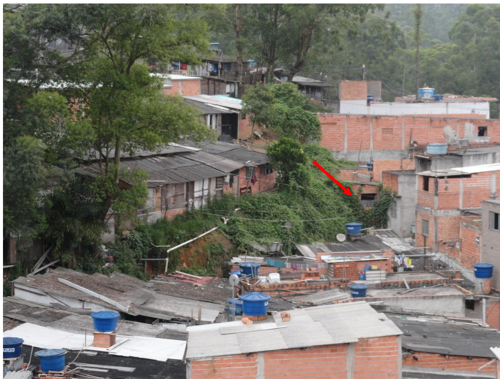
Foto FC-STA-20-03.01: Detalhe do talude de corte com altura elevada nos fundos das moradias do setor (seta vermelha).
