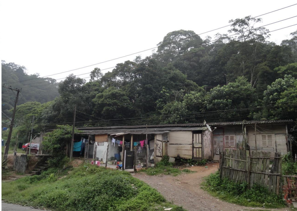
Foto FC-STA-31-01.02: Notar a distância das moradias com relação a base do talude de corte.
