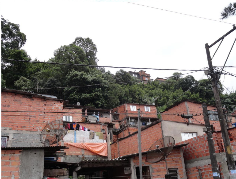
Foto FC-STA-19-03.02: Notar a média inclinação, a ausência de cortes elevados e o alto grau de consolidação do setor.
