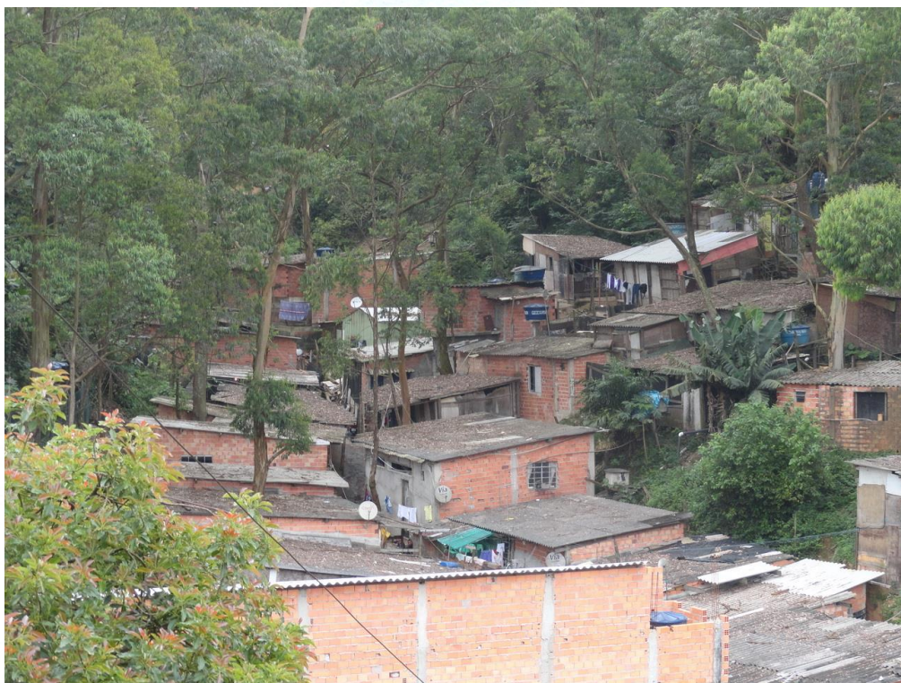
Foto FC-STA-20-01.02: Detalhe das moradias em meio a um dos anfiteatros de drenagem do setor.
