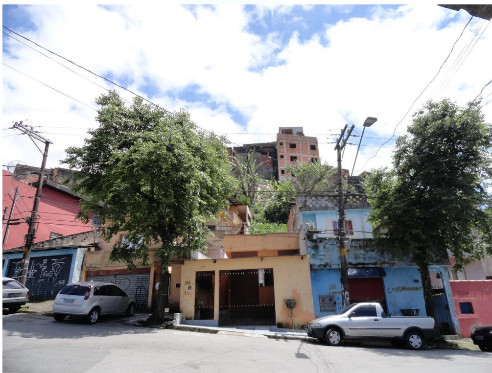
Foto FC-STA-19-01.02: Moradias de bom padrão construtivo no setor, na base do talude.
