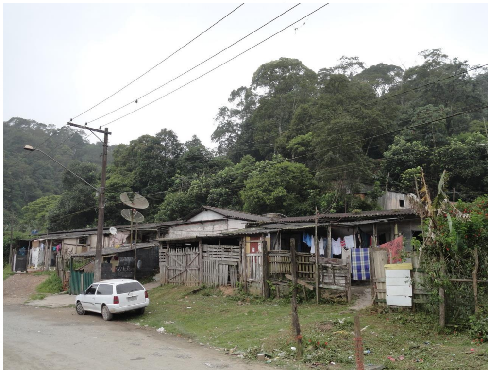
Foto FC-STA-31-01.01: Detalhe das moradias de baixo padrão construtivo no setor, na base do talude.
