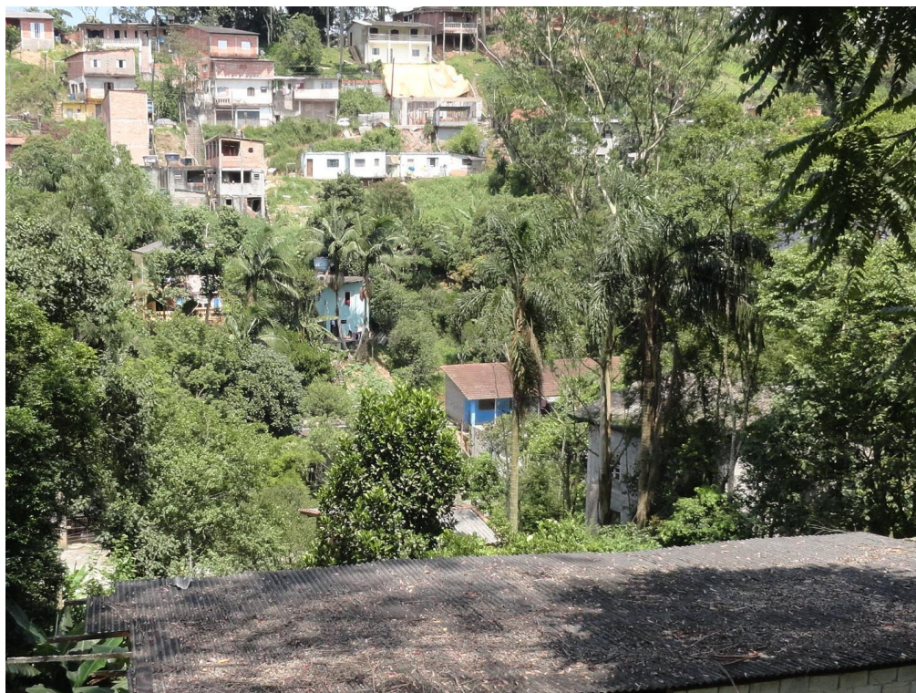
Foto FC-STA-28-01.01: Vista geral do setor. Notar a altura e inclinação elevada da encosta.
