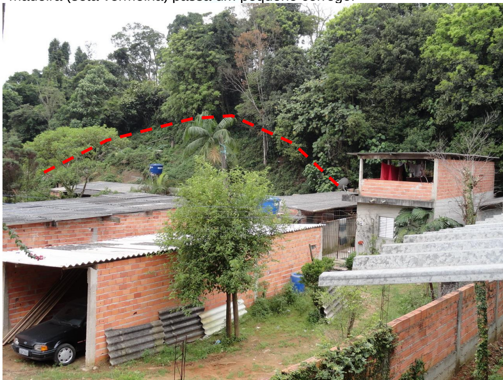
Foto FC-STA-22-01.02: Notar, no fundo das moradias, no talude de corte, a presença de uma grande cicatriz de deslizamento (tracejado vermelho).
