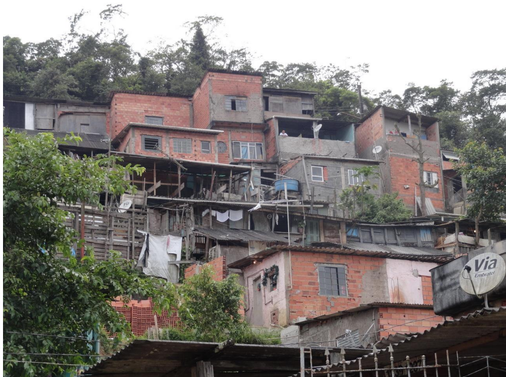
Foto FC-STA-25-01.01: Notar a elevada altura e inclinação da encosta.
