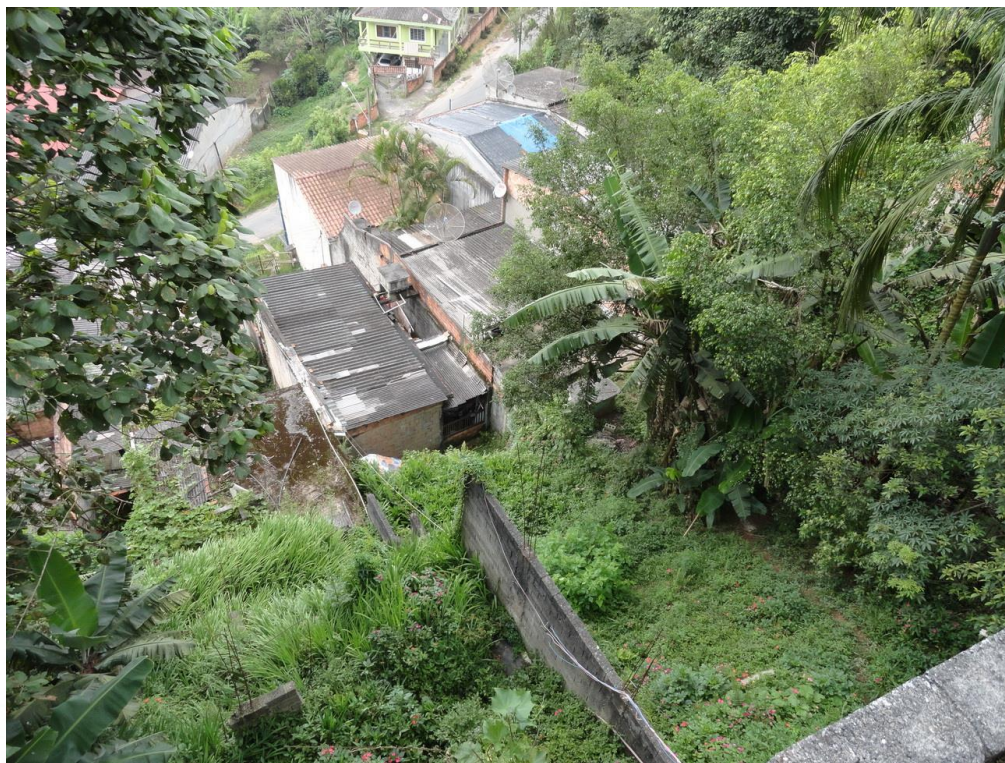
Foto FC-STA-24-01.01: Vista da moradias localizadas muito próximas a base da encosta natural, a qual apresenta altura e inclinação elevadas.
