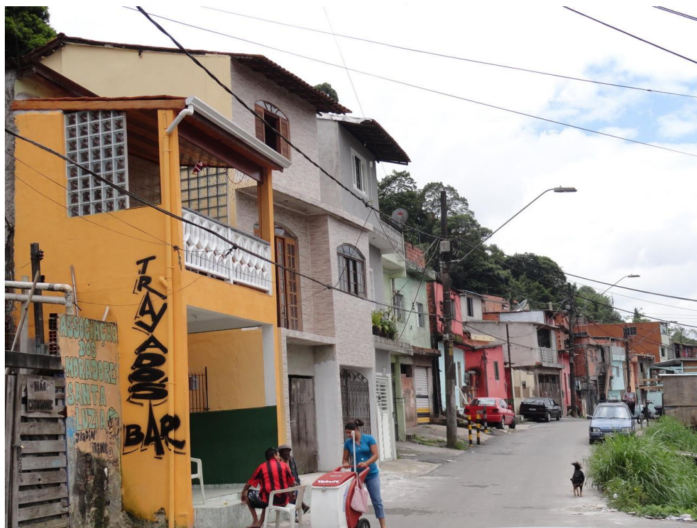
Foto FC-STA-19-03.01: Moradias de bom padrão construtivo em trecho de baixa declividade do setor.
