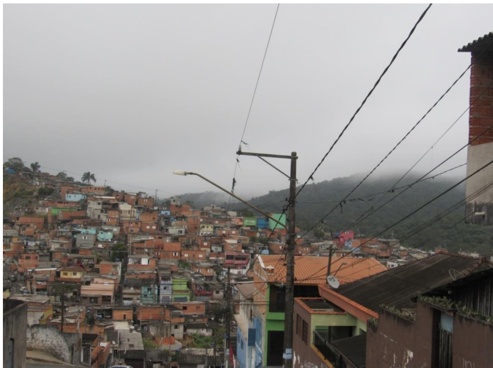
Foto 9. Área de consolidação com restrição IIA. Rua Toledana - Jardim Santo André - Santo André
