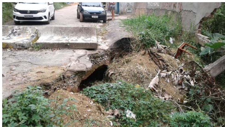
Limite da área atingida pelo processo. Evolução por pipping
