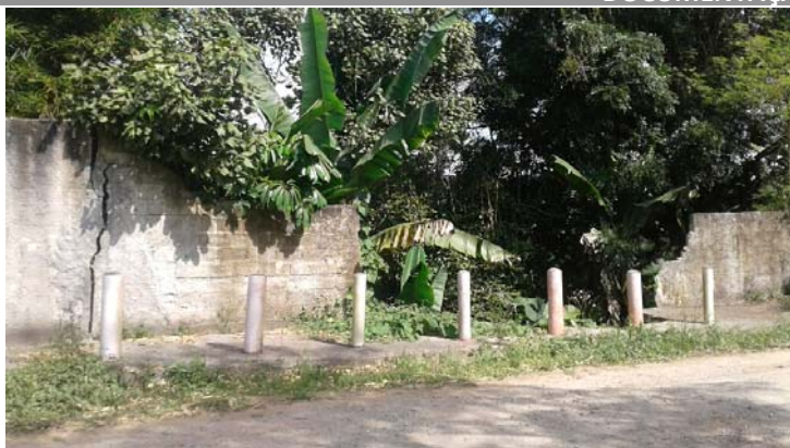
Imóveis afetados pelo processo.
