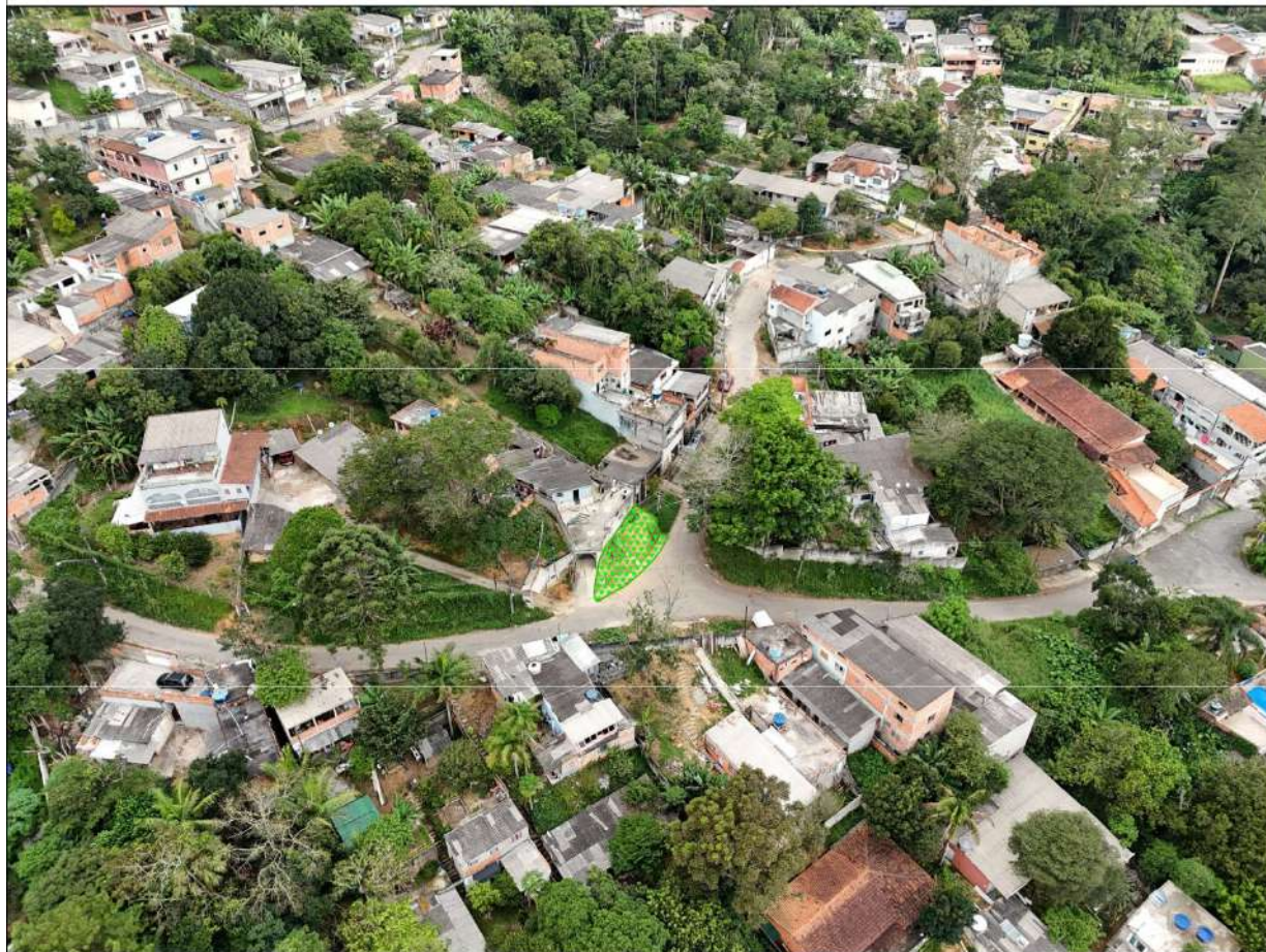
STA-A3-02 - Recreio da Borda do Campo - Rua Arara Azul
