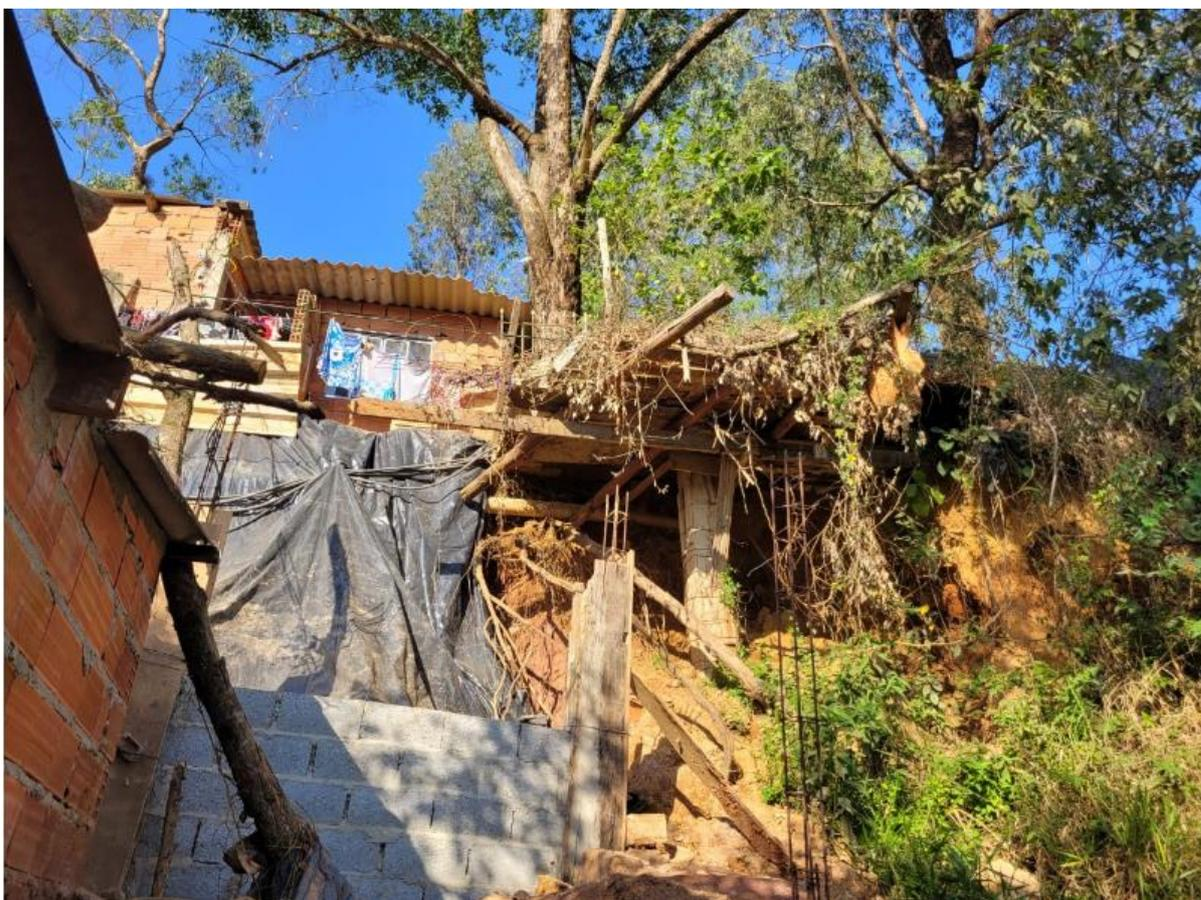
O Núcleo Nova Guaraciaba apresenta áreas com alto risco de deslizamento de terra, especialmente em face de ação antrópica. O local possui habitações precárias, construídas em madeiras e também em alvenaria, sem nenhum acompanhamento técnico. Não há vias oficiais. Muitas habitações não possuem acesso para veículos, o que pode dificultar no caso de um atendimento emergencial.
