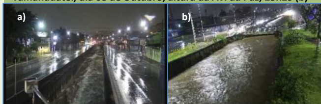
Figura 3 – Córrego Guaixaya em Avenida das Nações (a) e Rio Tamandateí, dia 08 de Outubro, altura da Av. da Paz, 23h29 (b)
