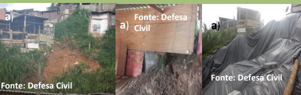
Figura 4 – Ocorrências: (a) Deslizamento: 04/02 - RUA DA PRAÇA - ASS. TOLEDANA - CDHU, 10 - (b) Queda de árvore: 01/02 - RUA TEIXEIRA DE FREITAS, 323. (c) Alagamento intransitável: 02/02 Rua Oratório;- (d) 12/02 Avenida dos Estados, no cruzamento com a Avenida André Ramalho
